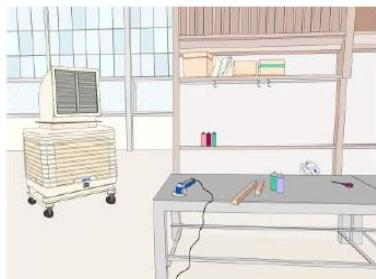
当工場では、作業スペース毎に冷やしたいエリアや空気の流れを促したいエリアに対してピンポイントに設置することにより、作業場を効率よく冷やし作業効率が向上しました。また、弊社工場はシャッターが解放されているので、水の気化に伴う湿度の上昇等は発生しませんでした。
